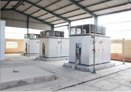
Hệ thống máy nén CNG
