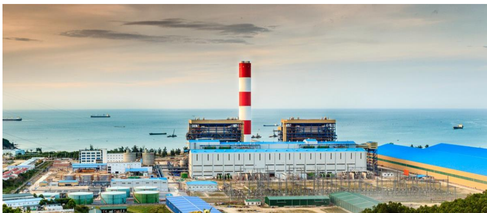
Dự án Nhà máy Nhiệt điện Nhơn Trạch 3 & 4. Ảnh: Cafef
